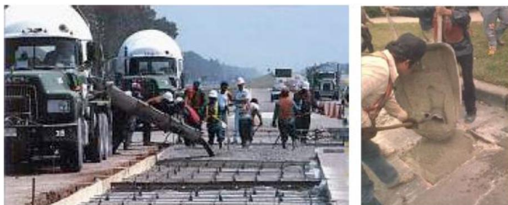
Figura 7: Uso do geopolímero Pyrament, nos Estados Unidos, como material de reparação de rodovias
