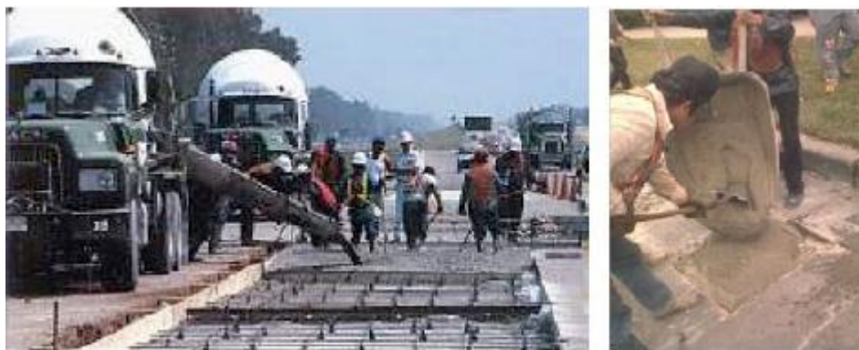
Figura 3: Uso do geopolímero Pyrament, nos Estados Unidos, como material de reparação
