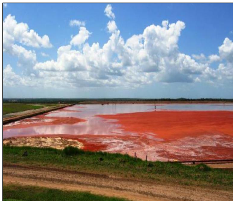
Figura 5 – Lagoa de disposição de lama vermelha da Alumar (Ilha de São Luís)
