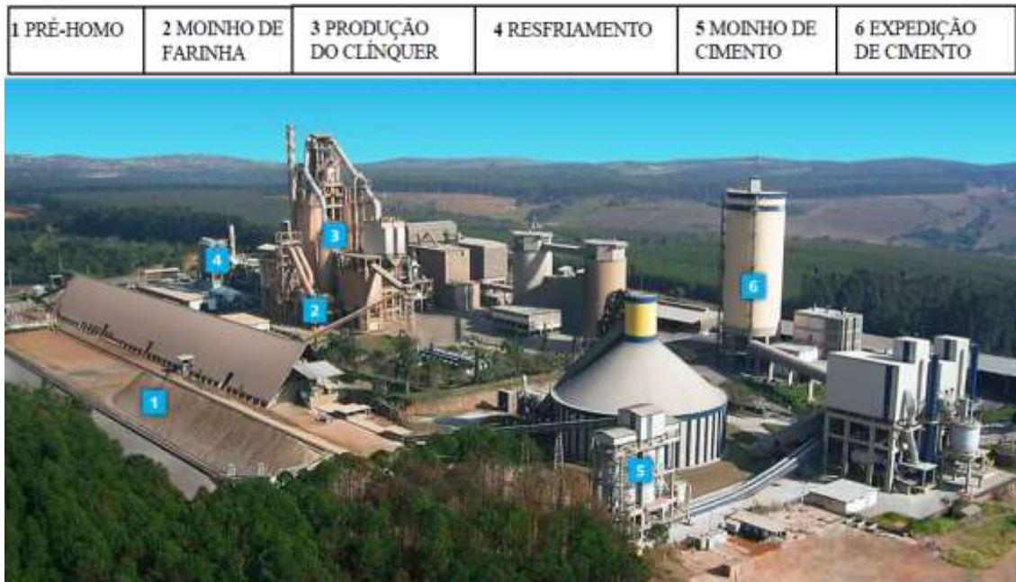
Figura 2: Processo de fabricação do cimento
