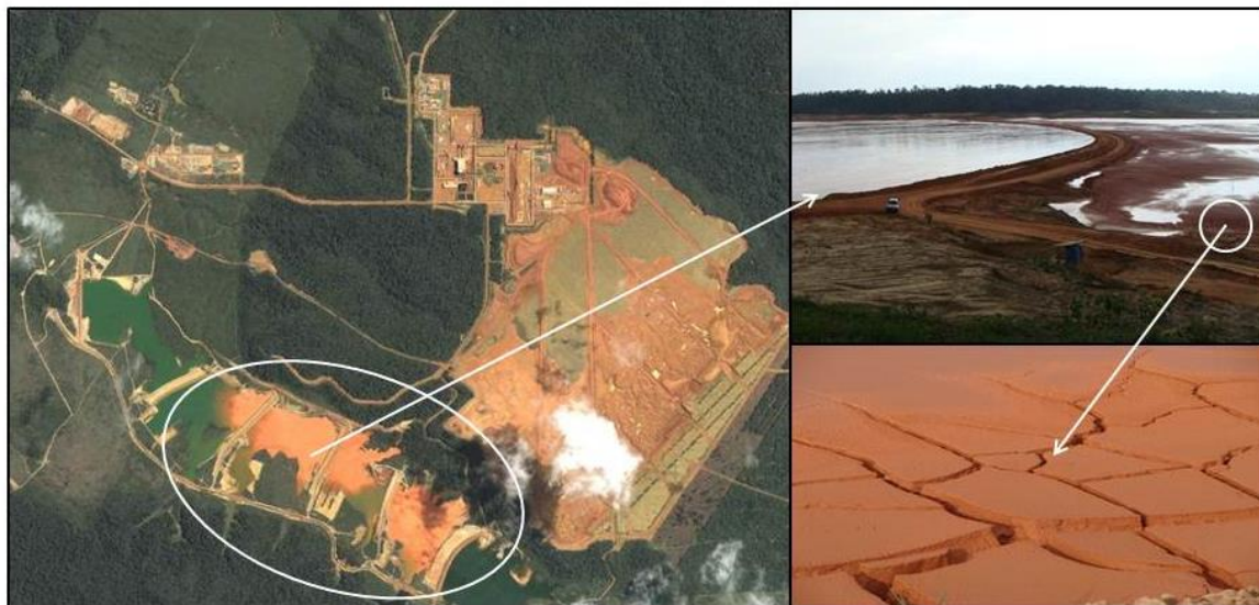
Figura 4 - Detalhe das lagoas de sedimentação da Norsk Hydro
