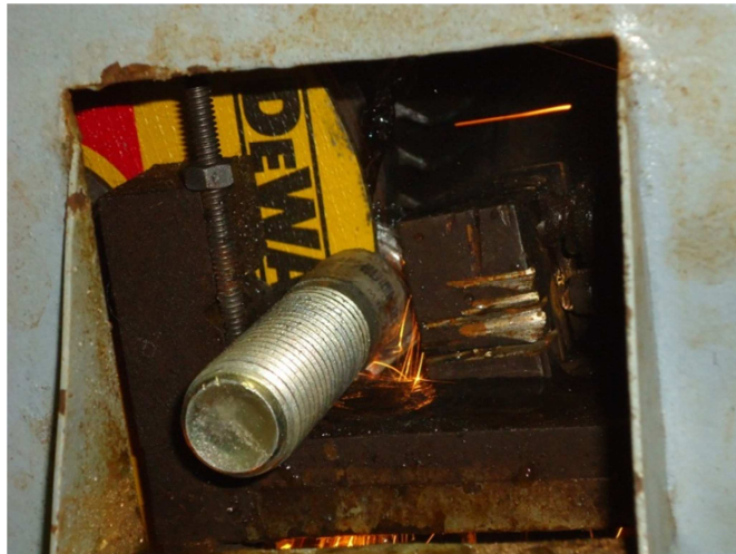
FIGURA 20 – Momento da retirada da cabeça do parafuso PN.
