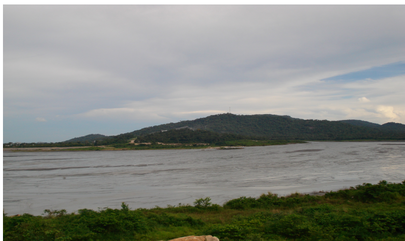
Figura 10 – Barragem de rejeito mina do sossego
